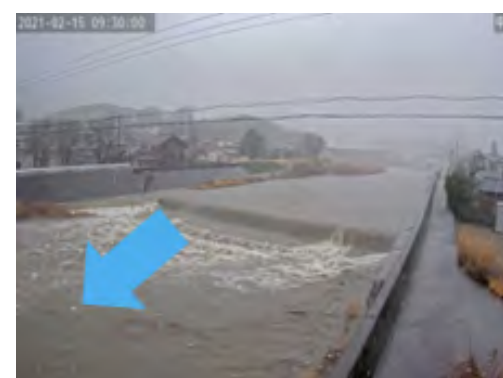
簡易型河川監視カメラ
