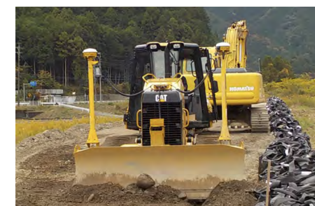
ICT建機施工状況
