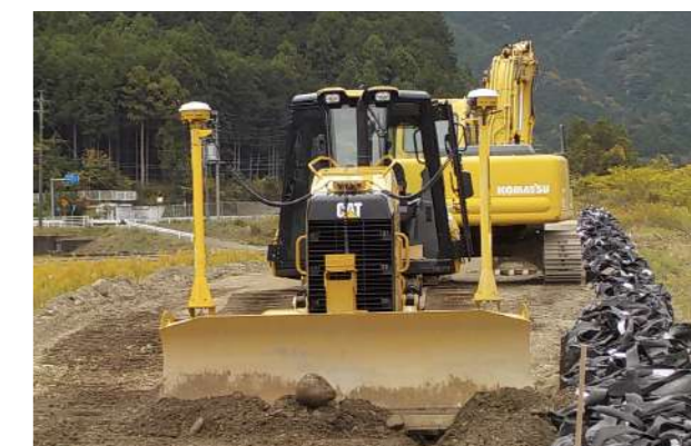
ICT建機施工状況
