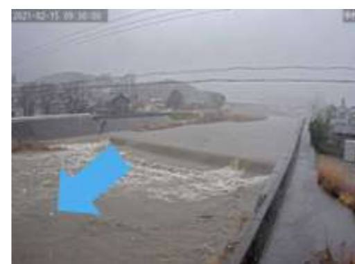
簡易型河川監視カメラ
