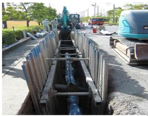
管路布設替えの状況
