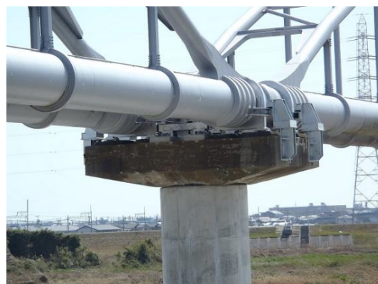
鈴鹿川第 2 水管橋の耐震化
