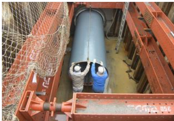
パイプインパイプ工法による管更生工事
