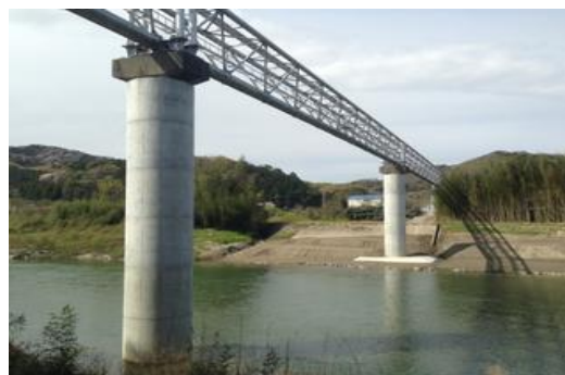
櫛田川水管橋下部工の耐震化
