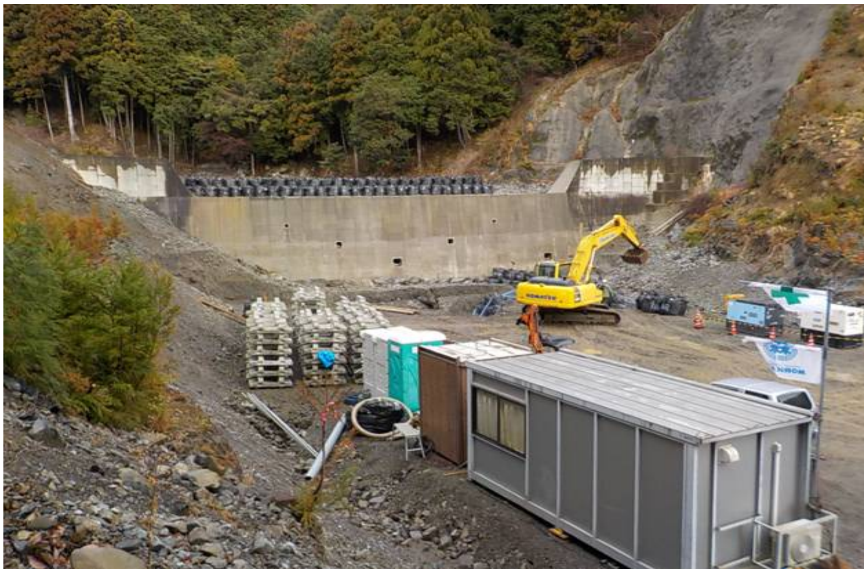
二級水系員弁川水系青川国補通常砂防（1号えん堤前庭保護工）工事
