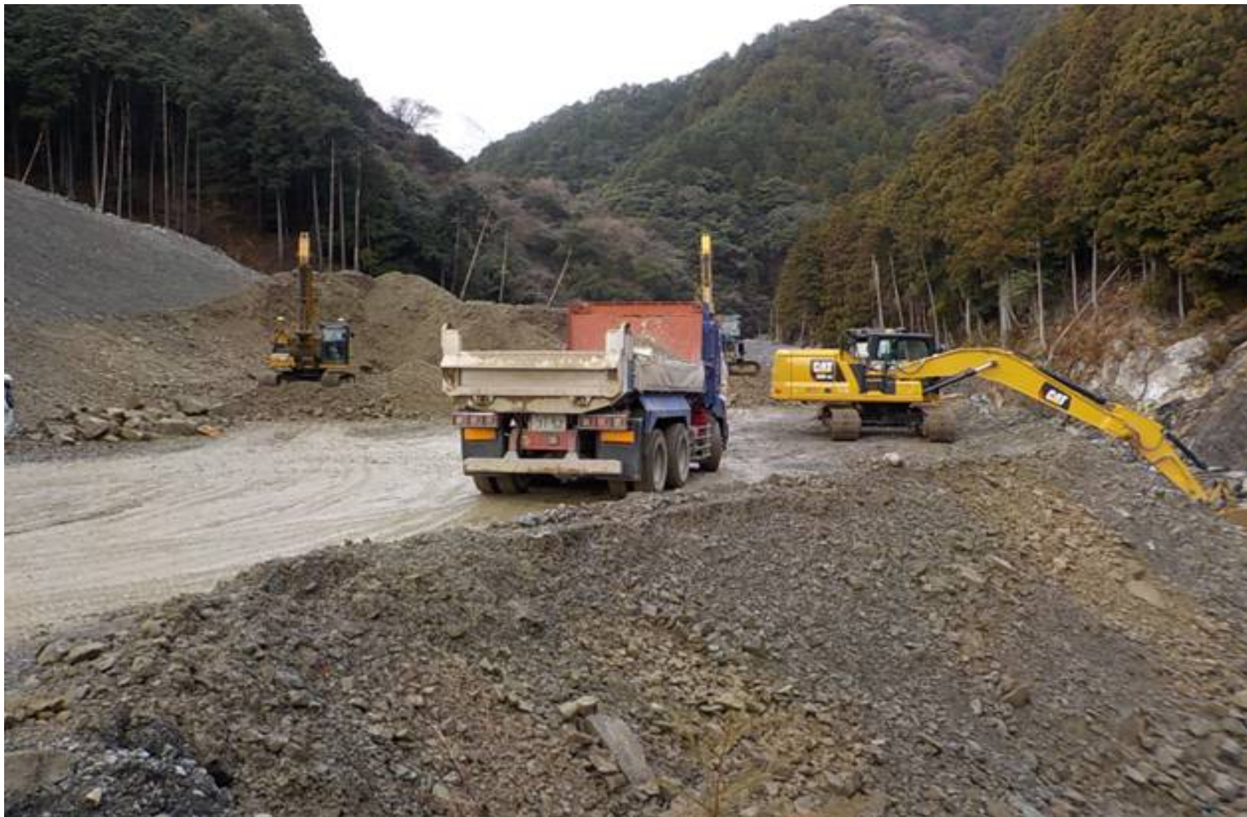
二級水系員弁川水系青川ほか1溪流砂防堆積土砂撤去工事（その2）
