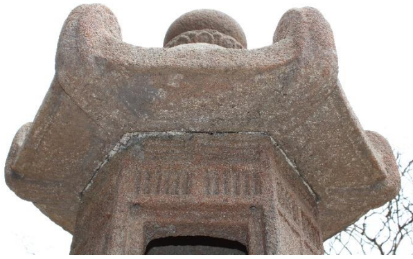
写真6 屋根軒下部・火袋上部
