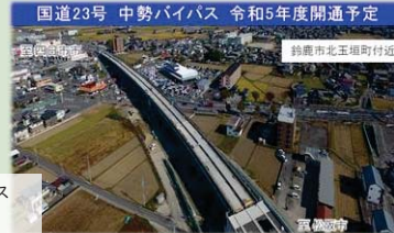
国道23号中勢バイパス整備箇所
