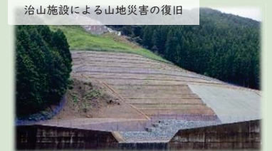
治山施設による山地災害の復旧
