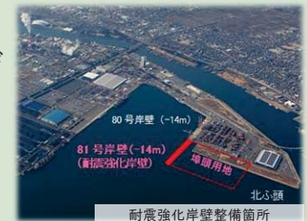
耐震強化岸壁整備箇所
