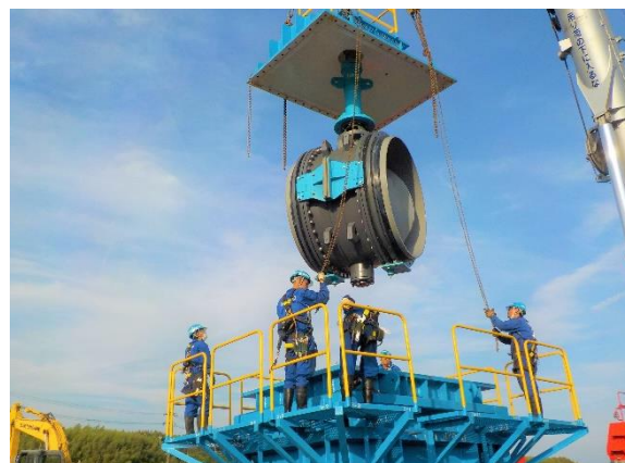
制水弁取替工事 ※ の施工状況 (内径 1800 耗制水弁 (桑名市))
