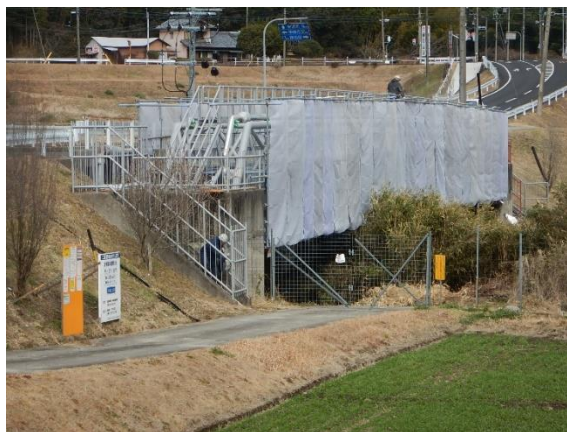
塗装塗り替え工事の施工状況 (長野川水管橋)
