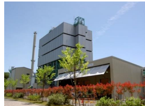
三重ごみ固形燃料発電所
