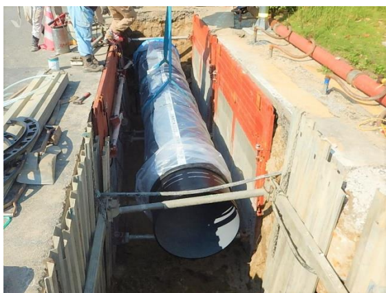
配水管布設替工事の施工状況 (内径 900 耗配水管 (四日市市))
