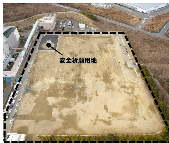
現況 (令和5年2月)
