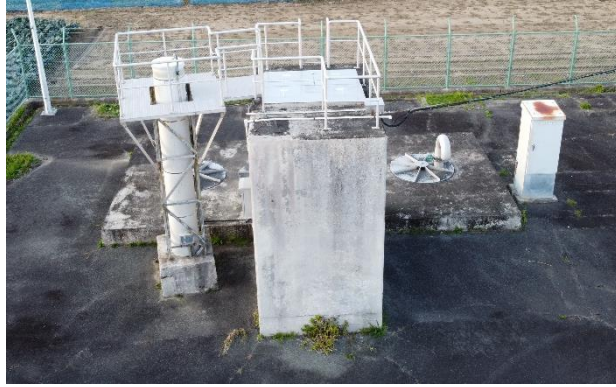
耐震補強予定の取水ポンプ井 (木造取水所)
