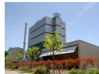
三重ごみ固形燃料発電所
