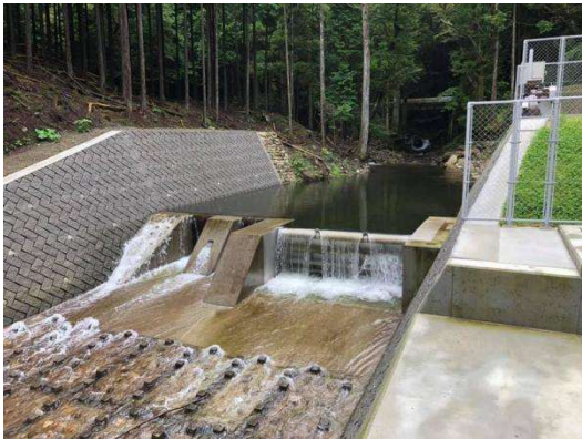
<馬野川小水力発電施設（取水口）>
