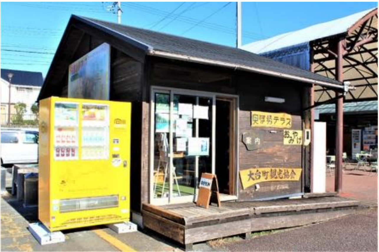
奥伊勢テラスの外観
