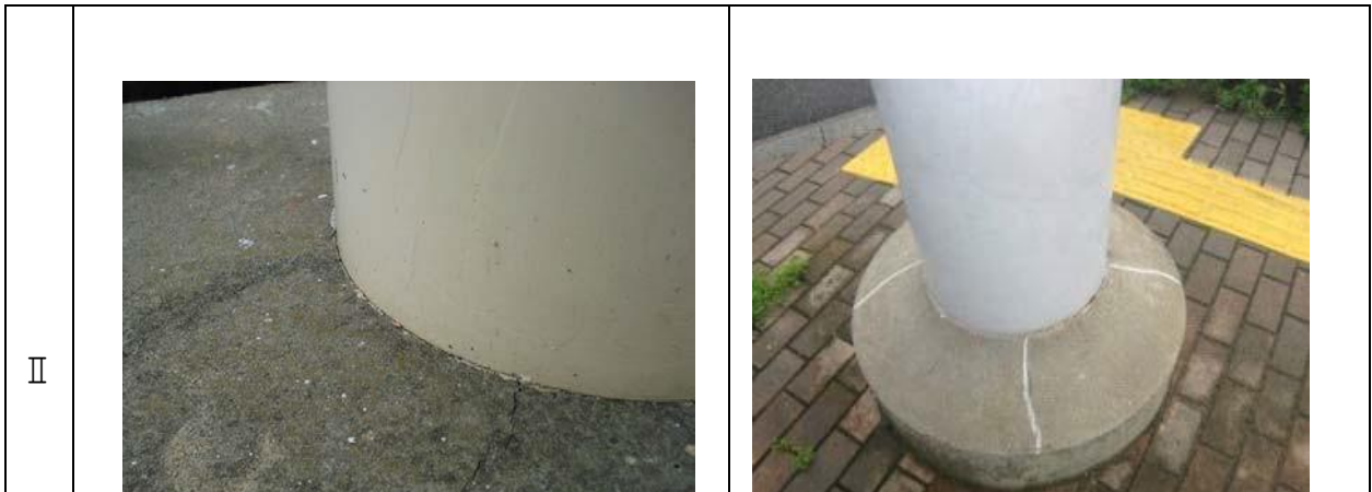
例：目視で視認できるひびわれがあり、放置すると雨水の内部への侵入などにより劣化が進展することが見込まれる場合
