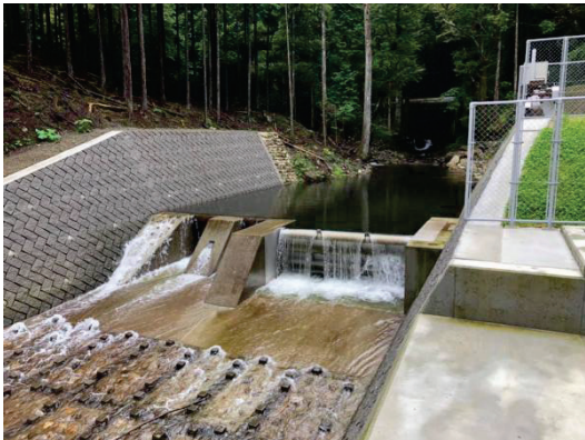
<馬野川小水力発電施設（取水口）>
