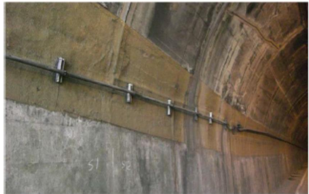
付写真-2.4.6 鋼板接着（左）・繊維シートの接着（右）例
