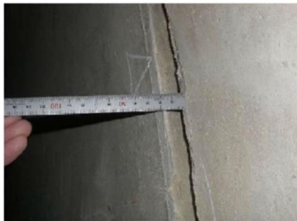
付図-2.4.5 目地部、打ち継ぎ目部の段差の例
