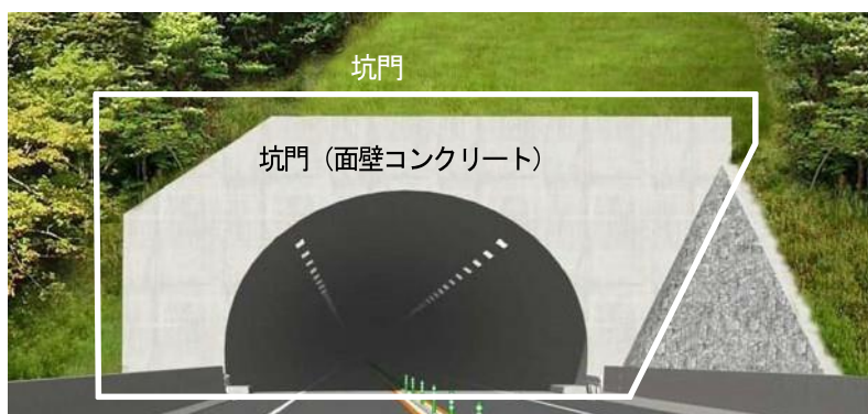
別図-1.2 点検対象箇所（トンネル坑口部）
