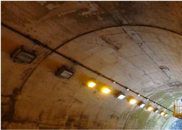
付写真-2.2.1 覆工の天端付近に発生した縦断方向のひび割れの例
