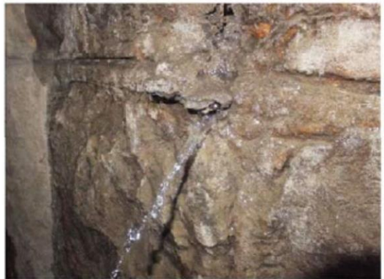
付写真-2.4.3 漏水（噴出）している例
