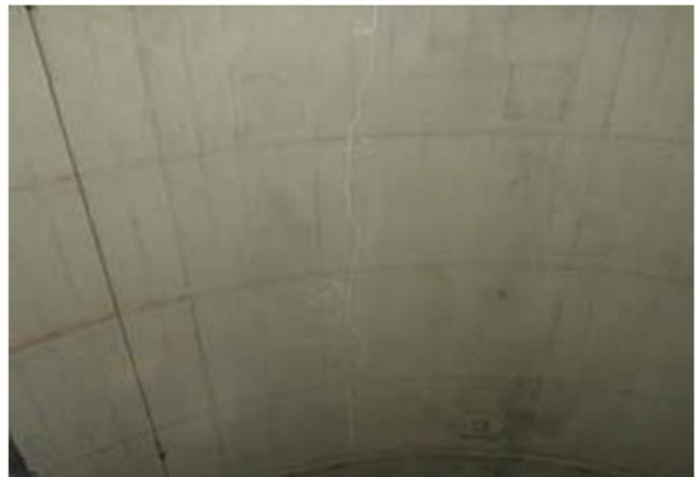
付写真-2.2.1 覆工の天端付近に発生した縦断方向のひび割れの例
