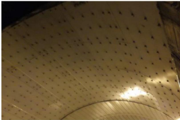
付写真-2.4.6 鋼板接着（左）・繊維シートの接着（右）例
