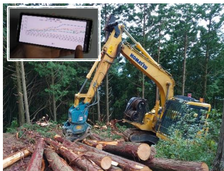
森林作業の生産性向上を目的とした、時間観測調査や工程管理を支援するツールの開発
