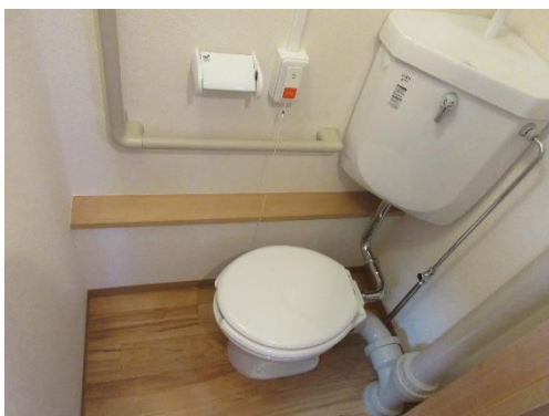
県営住宅における 高齢者仕様の整備事例(便器の洋式化等)
