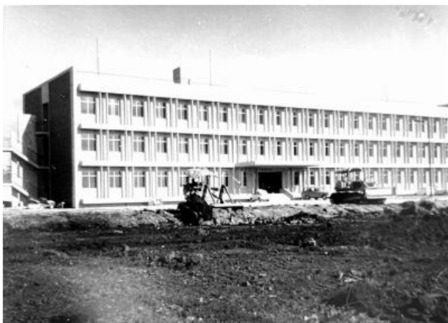
昭和44年11月28日 完成した本館玄関前、 8m道路整備の様子
