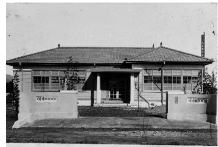
三重県茶業試験所（鈴鹿郡亀山町） 昭和12年3月撮影。
