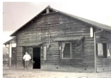
同左、園指仮事務所 近景
