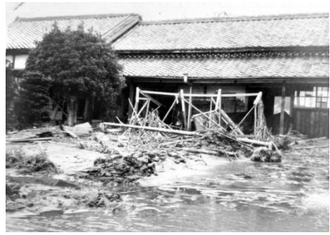
昭和28年9月25日台風13号による被害を受けた伊賀分場本館（上野市小田）
