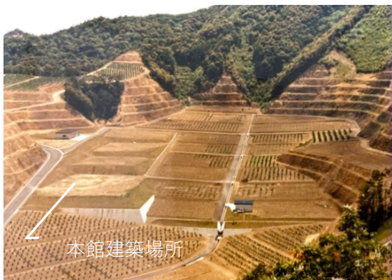
造成工事後の紀南かんきつセンター用地
