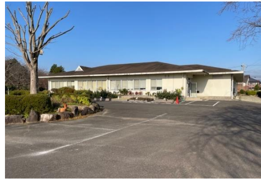
花植木センター本館
