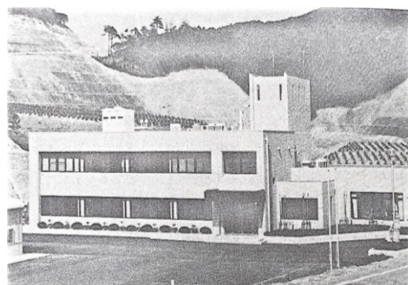
紀南かんきつセンター本館（S62）
