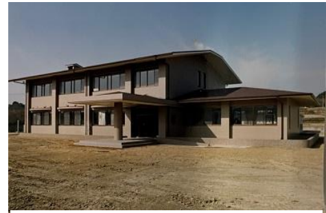
本館（平成 4 年、竣工時）
