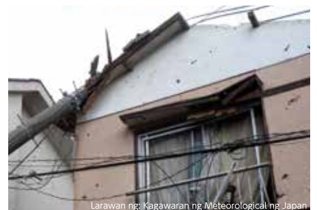
Larawan ng: Kagawaran ng Meteorological ng Japan Tirahan na nasira dahil sa bumagsak na poste ng kuryente
