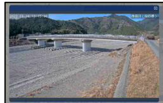
簡易型河川監視カメラ
