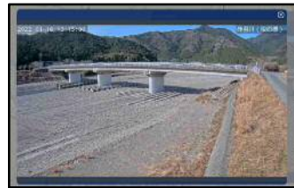
簡易型河川監視カメラ
