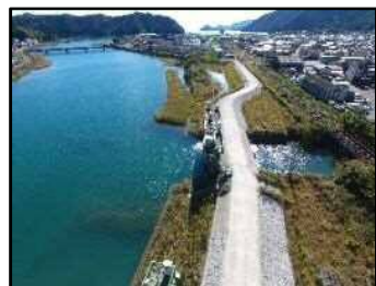
堤防強化事業(船津川) 【三重県】
