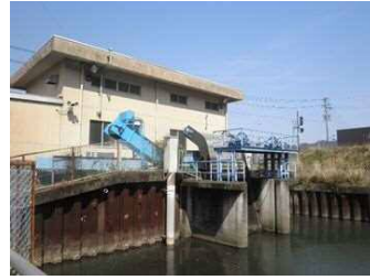
出垣内地区排水機場(排水機場整備) 【三重県】
