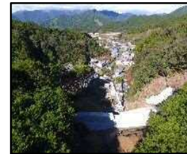
砂防堰堤の整備(猿谷) 【三重県】
