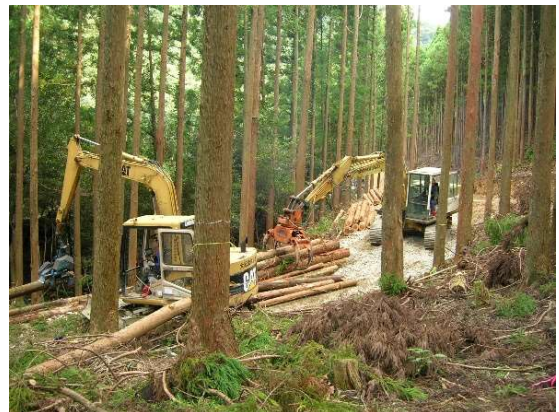
<高性能林業機械の連携作業>
