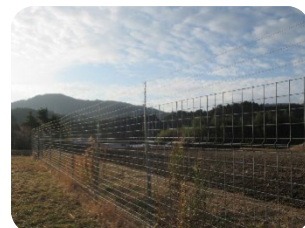
侵入防止柵の整備
