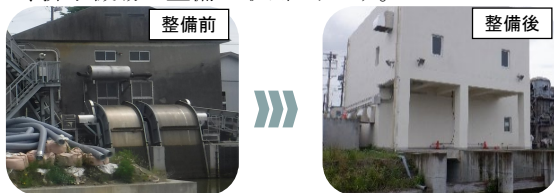
排水機場の耐震対策
