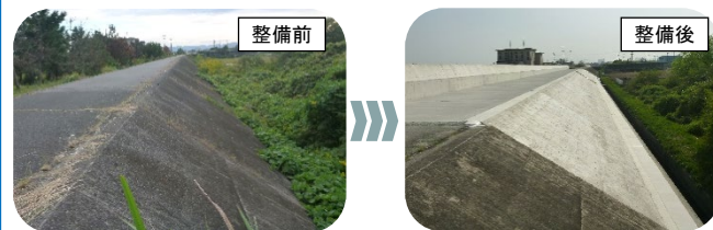
海岸堤防の耐震対策
