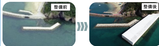
防波堤の整備
