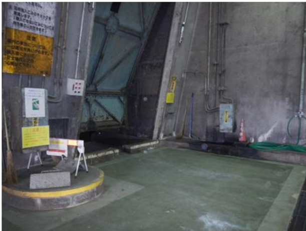
⑦作業終了後廃棄場所
