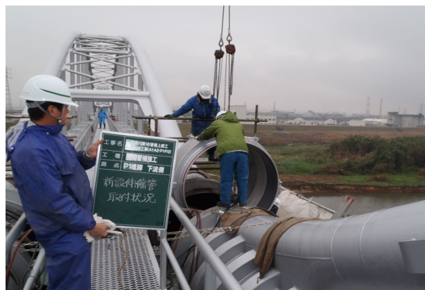
写真 水管橋の耐震化工事に伴い伸縮管を取替
