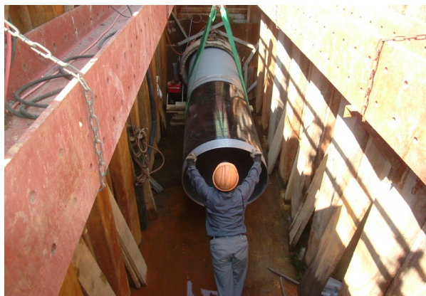
写真 PIP工法による管更生工事 (薄肉鋼管挿入状況)
