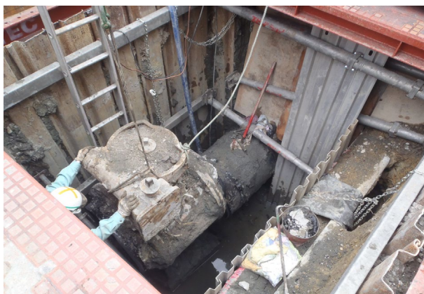
写真 全閉のまま固着したバタフライ弁の撤去状況
