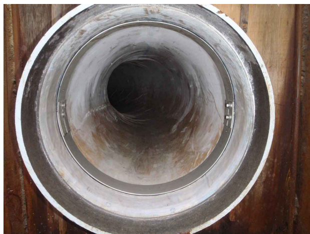
写真 反転工法による管更生工事(管端部)
