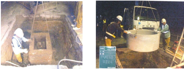
写真 四角の狭隘な弁室をφ1200の弁室に取替える
