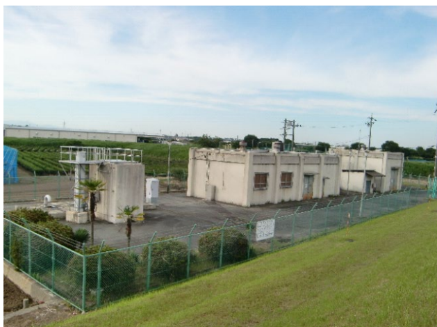
図-5 木造取水所
