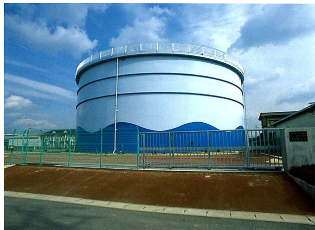
図-6 大口配水池
