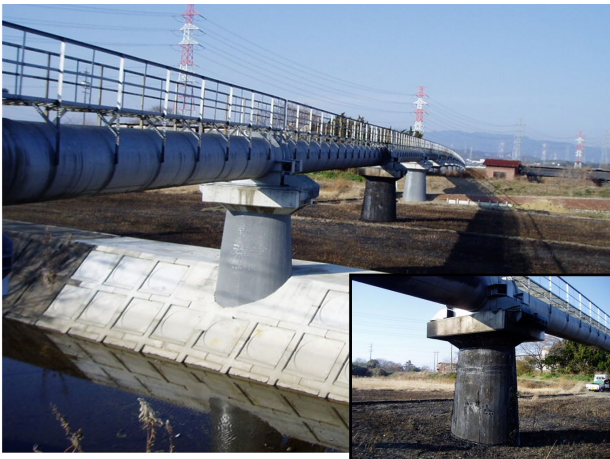
図-10 員弁川水管橋
