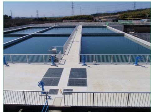
図－17 沢地浄水場耐震補強工事
