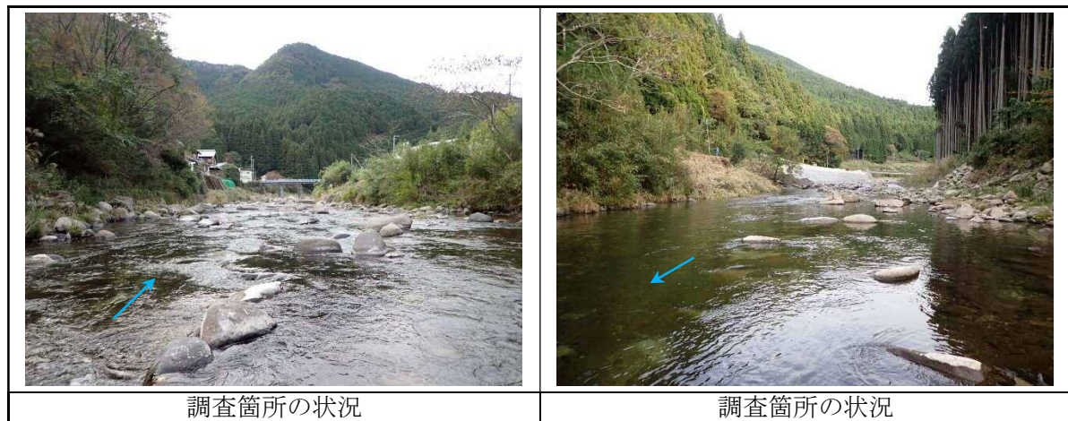
図 5.1.1 調査箇所の状況（工事着手前：令和4年10月27日）
