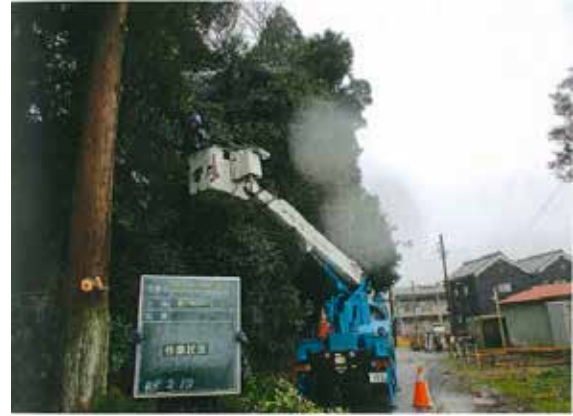
危険木伐採事業 通学路沿いの危険木の伐採状況
