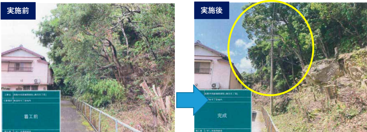
危険木伐採事業 人家裏の危険木を除去
