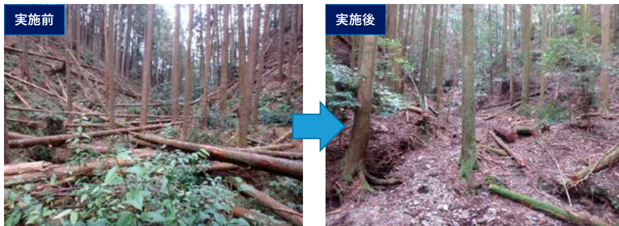
対策区分1：土砂や流木による被害を出さない森林づくり 溪流倒木等処理事業（大紀町）
