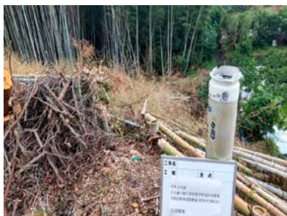
学校危険木伐採事業 中学校の危険木伐採後
