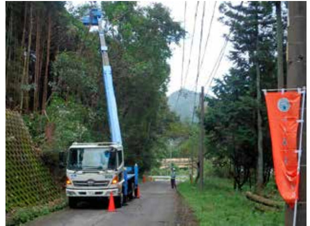
事前伐採の施工中の状況（亀山市）
