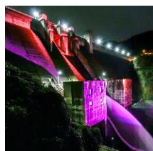
インフラツーリズム (君ヶ野ダムライトアップ)
