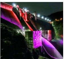
インフラツーリズム (君ヶ野ダムライトアップ)
