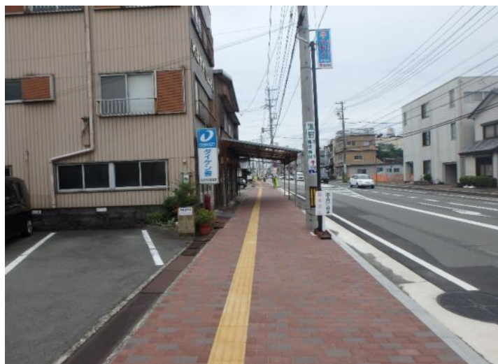
電線共同溝の整備中の状況(電柱撤去前)
