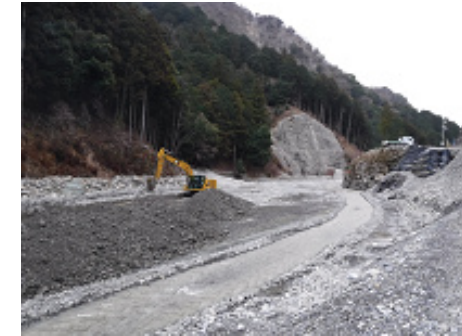
砂防堆積土砂撤去事業 （三重県）
