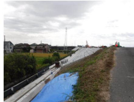
員弁川堤防強化事業 （三重県）
