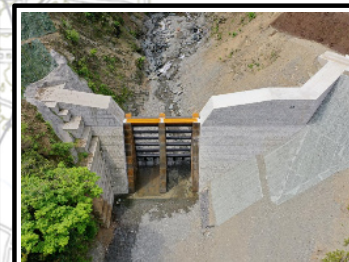
砂防堰堤整備（三重県）
