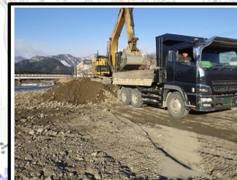
河川堆積土砂撤去（三重県）
