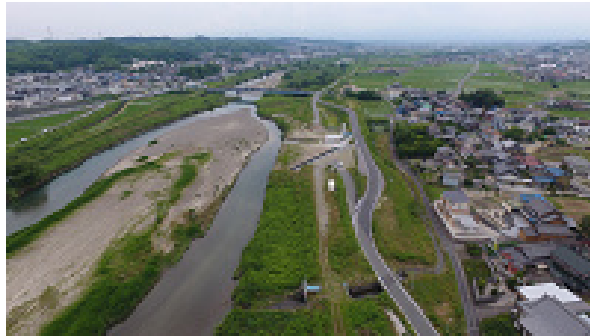
員弁川河川改修事業 （三重県）
