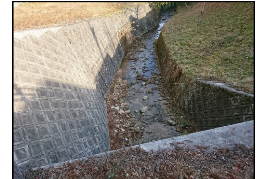
雲田川における浚渫 （菰野町）
