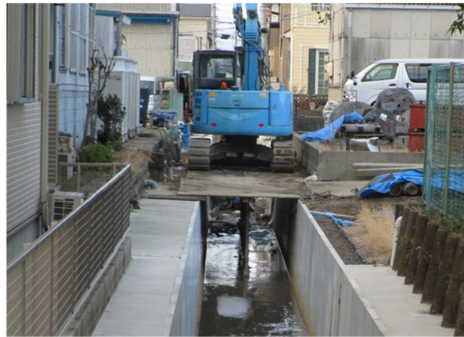
下水道（雨水排水）施設の整備
