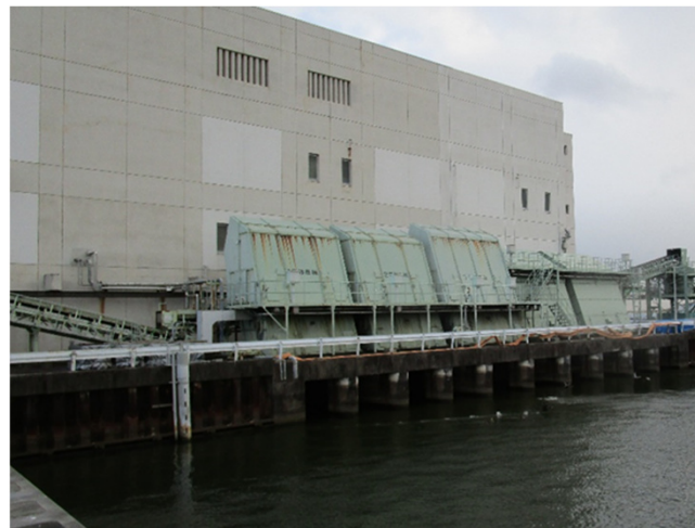
ポンプ場整備
