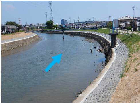
岩田川における築堤護岸 （三重県）
