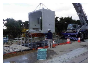
町屋第二雨水幹線 □2000×2000mm
