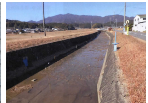
津市内河川における河道掘削 （津市）
