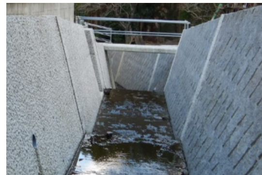
津市内河川における河道拡幅 （津市）
