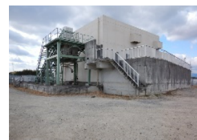
半田川田ポンプ場
