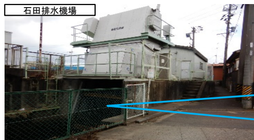
石田排水機場
