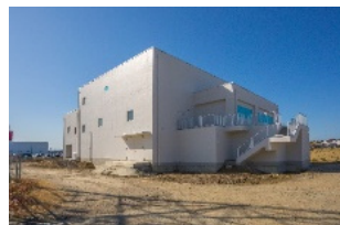
天神ポンプ場
