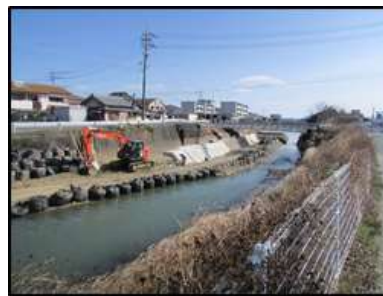
外城田川河道掘削 (玉城町)
