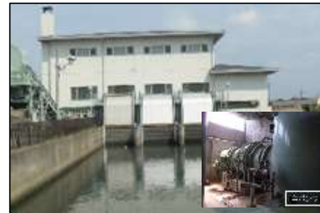
江川排水機場施設の延命化 (三重県)
