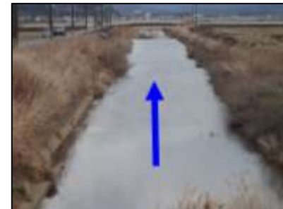
外城田川河道掘削 (多気町)
