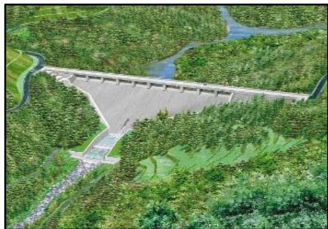
鳥羽河内ダム建設事業 (三重県)
