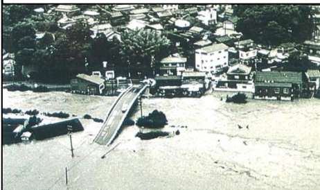
平成27年9月豪雨時浸水状況
