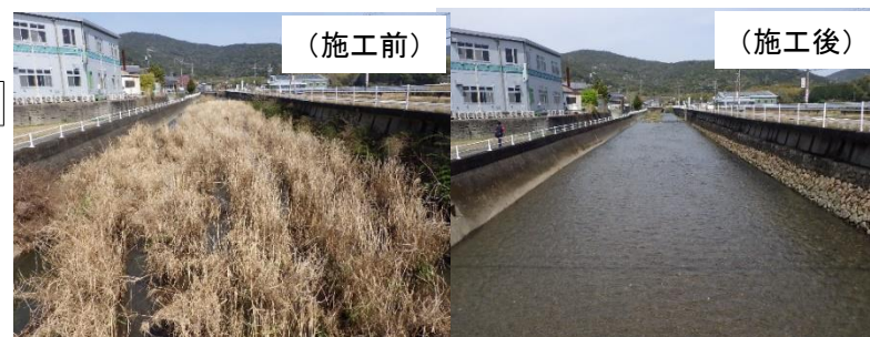
磯部川緊急浚渫推進事業 (三重県)
