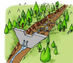
砂防堰堤堆積土砂撤去
