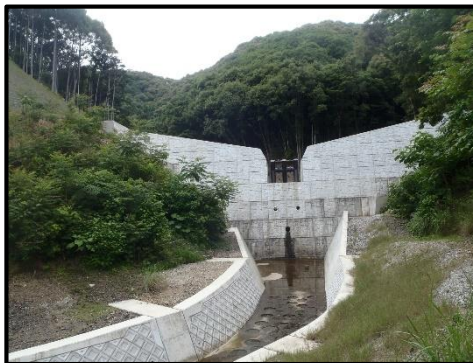
砂防堰堤の整備 (ヨドロ崎) 【三重県】
