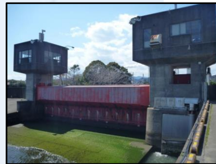
神内川防潮水門
