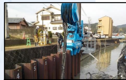
神内川護岸整備状況 (紀宝町役場付近護岸整備工事)
