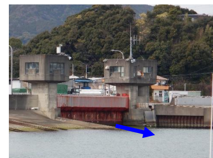
神内川防潮水門の現況
