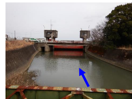
神内川防潮水門の現況
