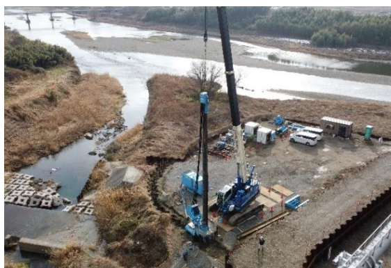
油の拡散を防止する鋼矢板の設置
