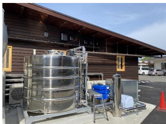
写真-7. 雨水利用施設
