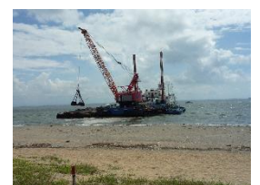
図6 堆積土砂を用いた干潟の造成
