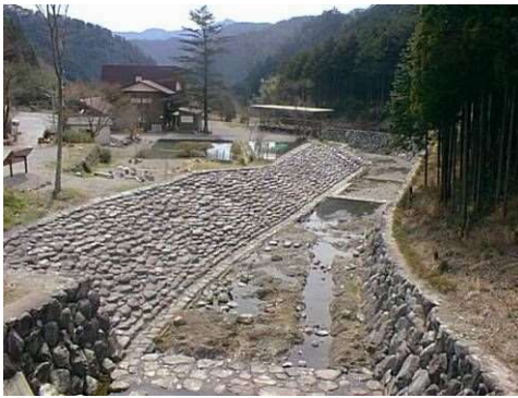
【流路工等（溪流保全工）】
