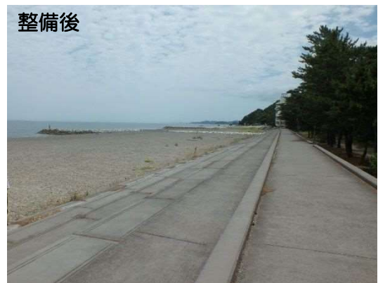
【護岸・養浜】 夫婦岩を訪れる人の利用や景観に配慮した、階段式護岸・突堤・養浜を組み合わせた海岸整備 (二見地区海岸／伊勢市)
