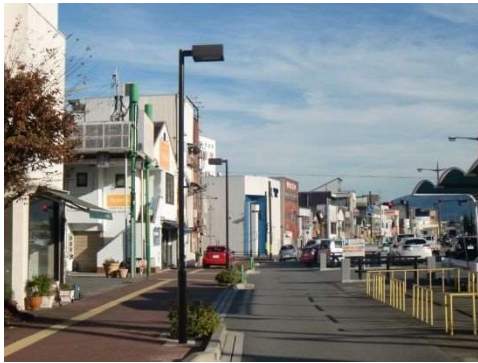
【色彩】 無電柱化により、スリムになった街並み に対し、シンプルで目立たないものを使用 (都市計画道路外宮度会橋線/伊勢市)
