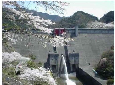
【ダム本体及び周辺構造物】
