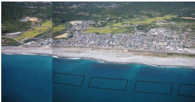
【離岸堤・突堤】 潜堤（人工リーフ）を採用することにより、安全性を確保するとともに、良好な景観を確保 (阿田和地区海岸／御浜町)
