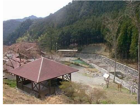
【流路工等（溪流保全工）】
