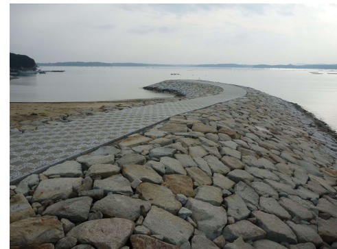
【離岸堤・突堤】 自然石を用いた穏やかな曲線の突堤と海浜遊歩道により、潤いのある空間を創出 (的矢港海岸／鳥羽市)
