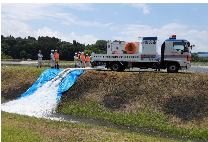
(排水ポンプ車作業状況①：出展 国土交通省)
