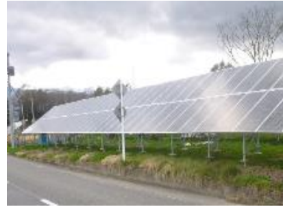
柵塀の設置されない設備
