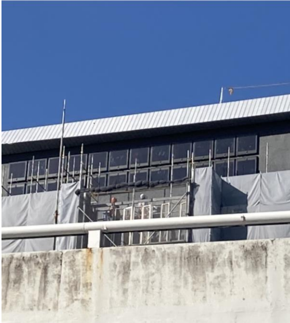
建物壁面への実装工事の様子 出所：積水化学工業（株）HP
