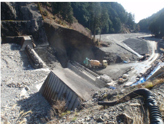
青川砂防（1号えん堤前庭保護工）工事
