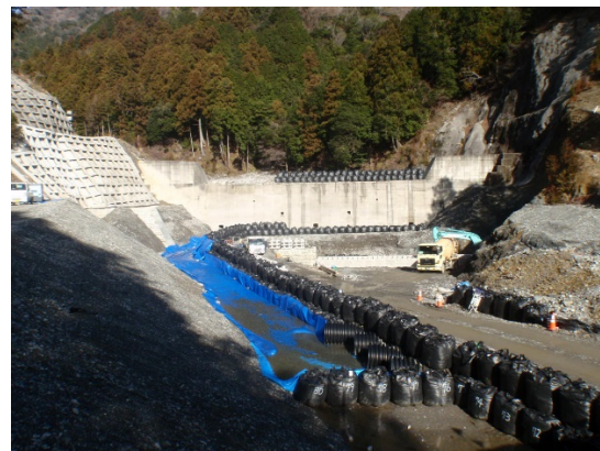
青川砂防（1号えん堤前庭保護工）工事
