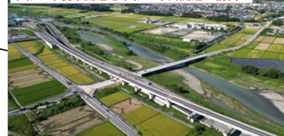
主要地方道 伊勢南島線 道路改良事業 (度会町)
