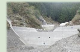
治山ダムの整備 (松阪市)
