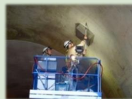
トンネルの点検
