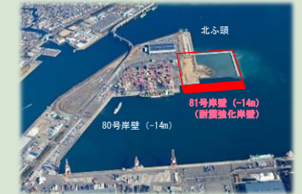
耐震強化岸壁整備箇所
