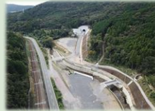
一般国道167号（磯部BP） （令和6年度開通予定）
