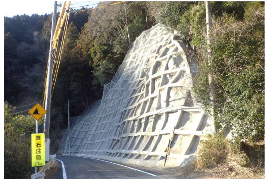
道路法面の安全確保
