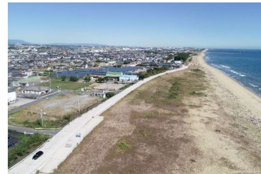
上野地区海岸高潮対策事業 (津市)
