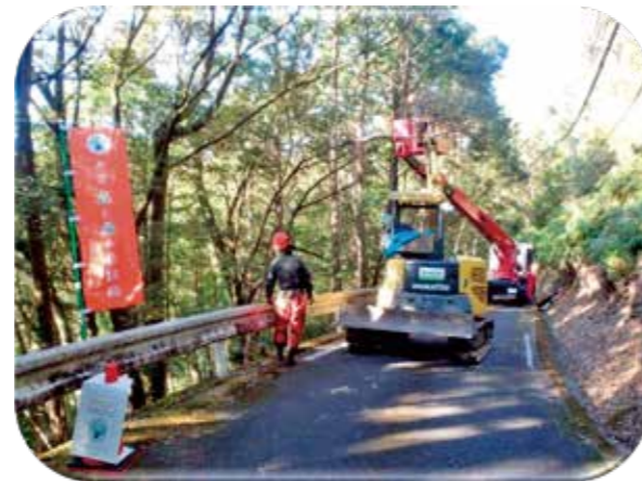
集落間を結ぶ生活道路沿いにおける危険木の伐採 (熊野市：暮らしを守る危険木伐採事業)
