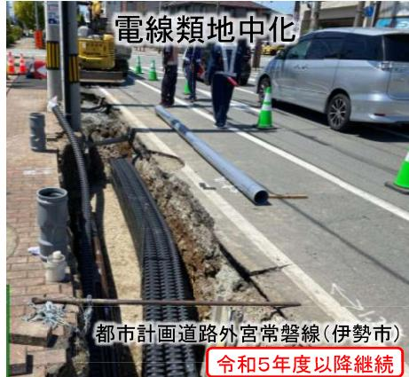
電柱倒壊による社会的影響が大きい市街地の緊急輸送道路において、道路閉塞を未然に防ぎ、大規模災害時の被害の軽減を図るとともに、救急救命・復旧活動に必要な交通機能を確保するため、無電柱化を推進
