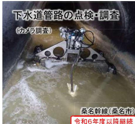
管路破損等による道路陥没事故の発生や機能停止を未然に防止するため、施設の重要度等を踏まえた効率的な下水管路の点検・調査や、劣化度等を踏まえた計画的な改築・修繕を推進
