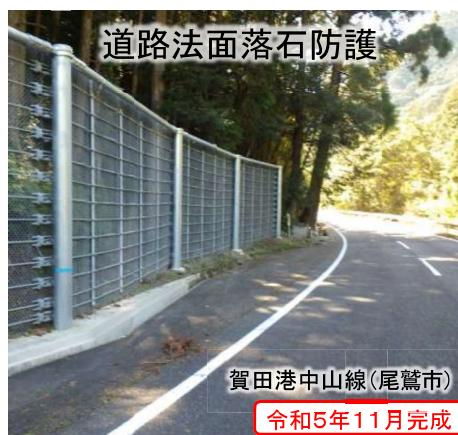
緊急輸送道路において、豪雨や大規模地震による土砂災害等の発生を防止するため、土砂災害の危険性がある箇所に対する道路法面・盛土対策を推進
