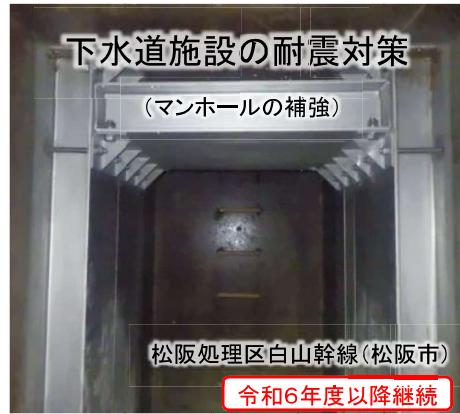
南海トラフ地震等の大規模地震の発生リスクが高まる中で、地震時の最低限の排水機能を確保するため、防災拠点や病院等の重要施設に係る下水管路や下水処理場の耐震化を推進
